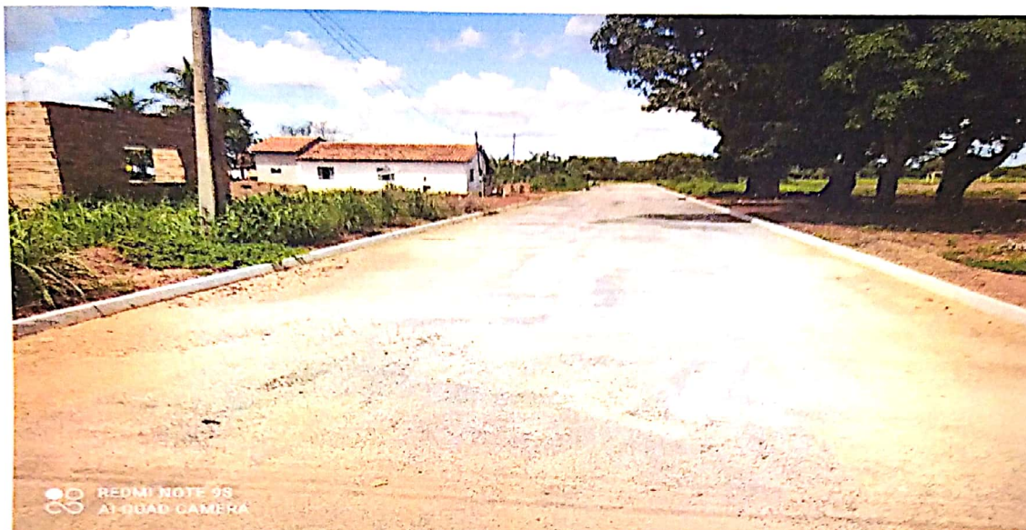
(Rua 14 entre as avenidas maranhão e piaui) FONTE: CONSTRUBASE ENGENHARIA
