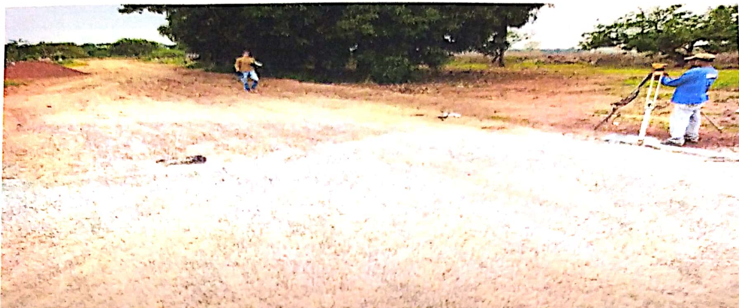
(Rua 14 entre as avenidas maranhão e piauí) FONTE: CONSTRUBASE ENGENHARIA
