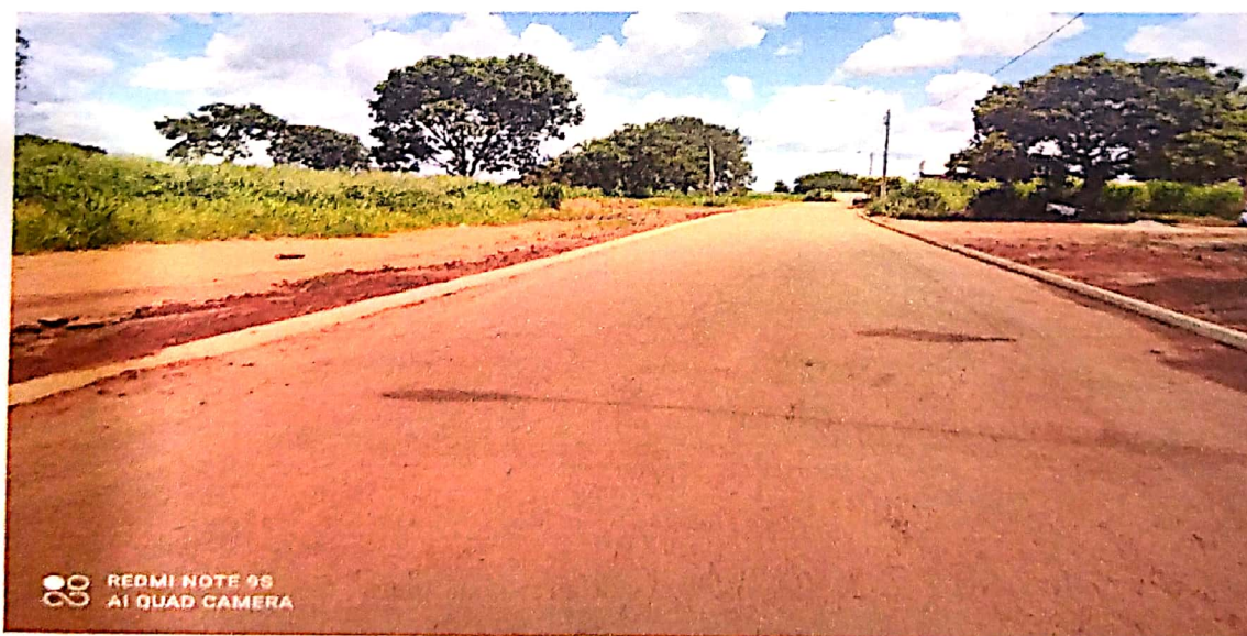
(Avenida Federal da rua 13 ate a Parque de exposição agropecuária) FONTE: CONSTRUBASE ENGENHARIA
